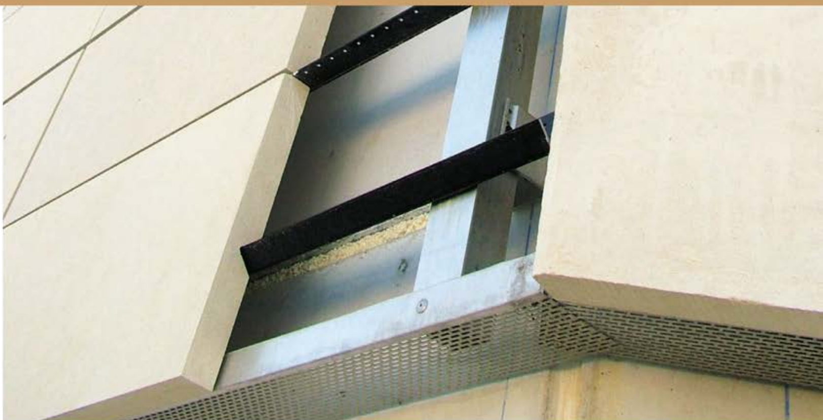
Esempio di lastre squadrate per facciate ventilate. Example of ventilated wall-cladding installed with anchoring system.
