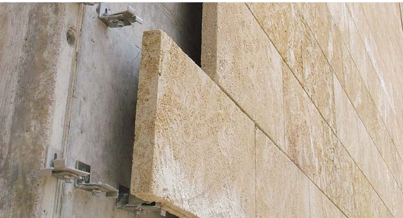
Esempio di lastre squadrate per facciate ventilate. Example of ventilated wall-cladding installed with anchoring system.
