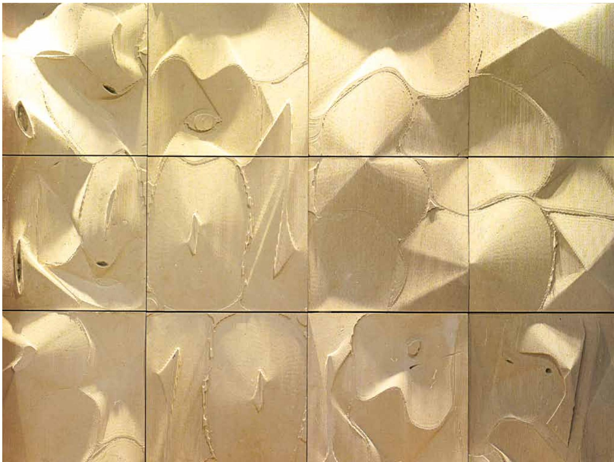
**"ALVEARE"** - LA PIETRA, COME MATERIALE COSTRUTTIVO VERO E PROPRIO, E' STUDIATA PER LA COSTRUZIONE DI VOLTE A BOTTE DECORATE E TRAFORATE, ASSEMBLATE GRAZIE ALL'UTILIZZO DI POCCHI CONCI AUTOPORTANTI REALIZZATI SECONDO TECNICHE DI TAGLIO ASSISTITO CAD - CAM E MACCHINE CNC.
